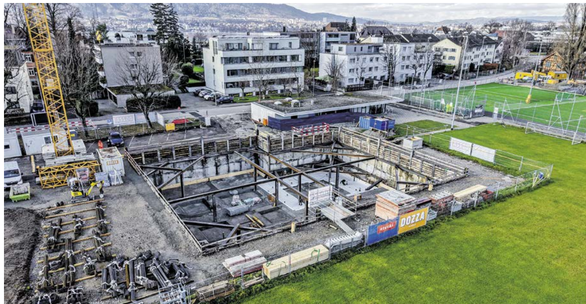
Baustelle der Fernwärmezentrale auf dem Fussballplatz Zollikon (Bild: JEUCH ARCHITEKTEN)
