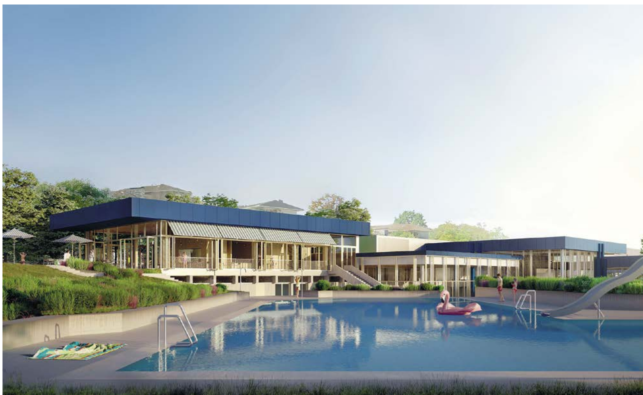
Fohrbach nach Sanierung inklusive Gastronomieneubau
