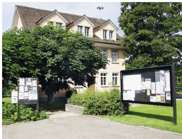
Einer der Standorte, wo bei Bedarf eine Abgabestation der Notwasserversorgung eingerichtet werden kann: Schulhaus Limberg, Küsnachter Berg
