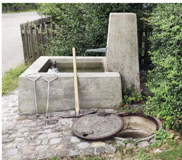
Inbetriebnahme eines Brunnen im Frühling
