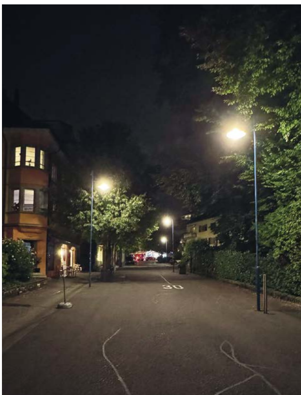
Neue LED-Leuchten in der Bahnhofstrasse Erlenbach
