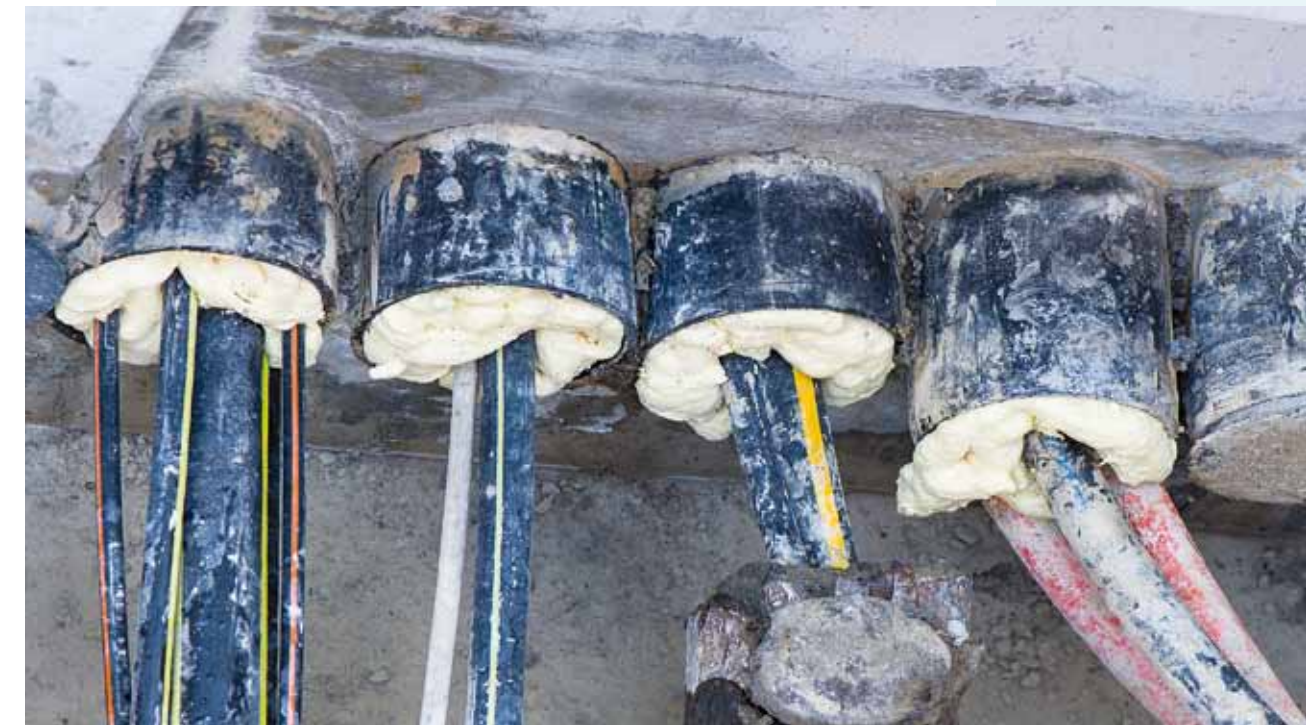
Rohrabdichtung in einer Schachteinführung
