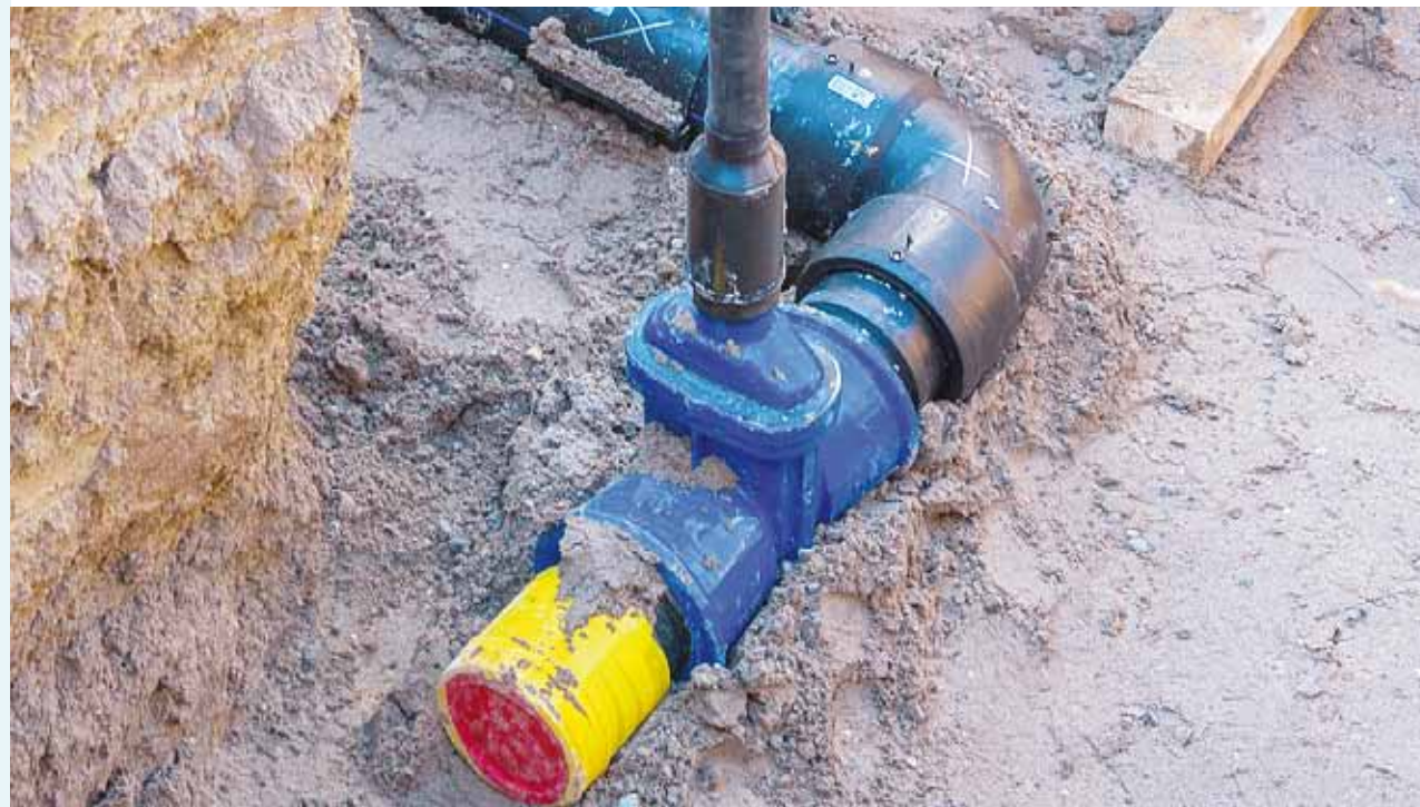
Neubau PE 160 Wasserleitung inklusive Absperrorgane
