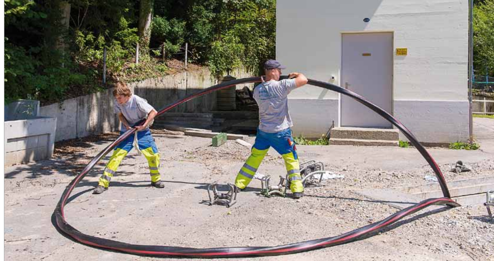
Handarbeit bei einer MS-Kabeleinschlaufung in eine Trafostation
