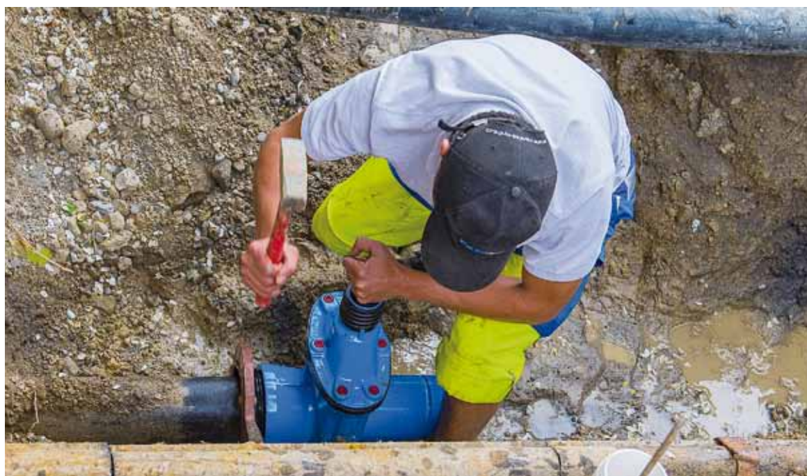
Montage eines neuen Wasserschleibers
