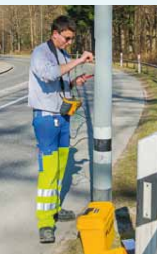
Arbeiten an einem Kandelaber
