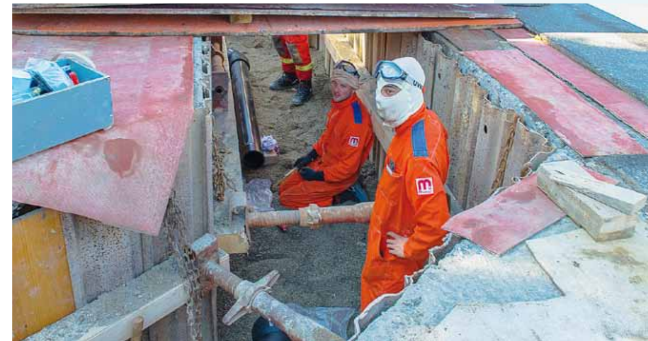
Arbeiten an einer gasführenden Leitung (Forchstrasse)
