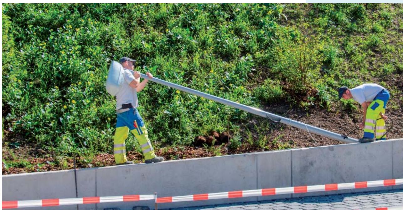
Aufstellen eines Kandelabers
