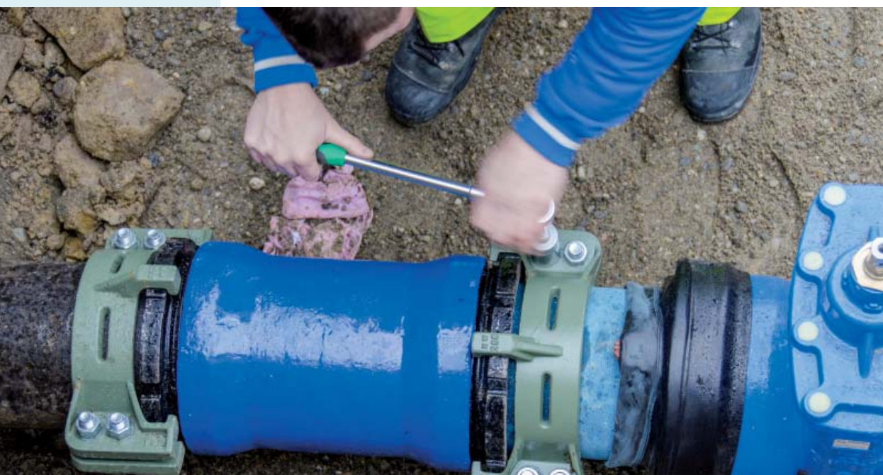
Anziehen einer Schubsicherung
