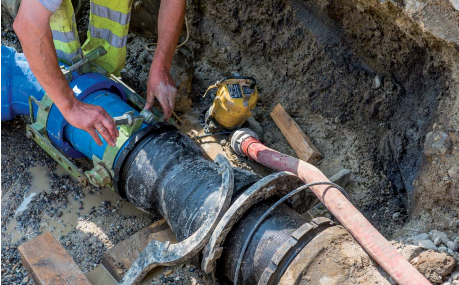
Arbeiten an einer Hauptleitung im Wasserversorgungsnetz
