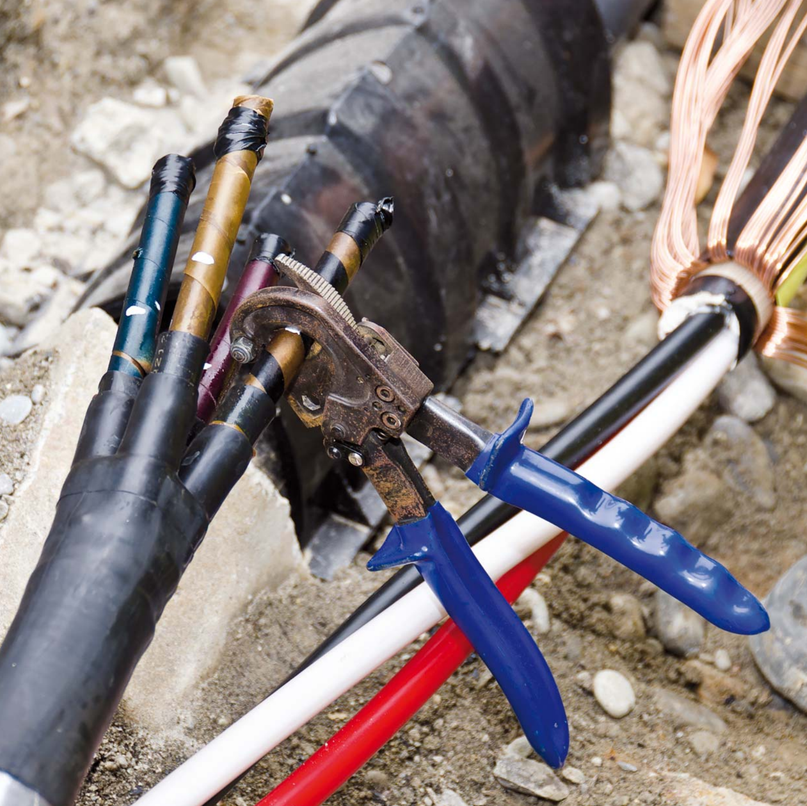
Vorbereitungsarbeiten für eine Niederspannungsmuffe
