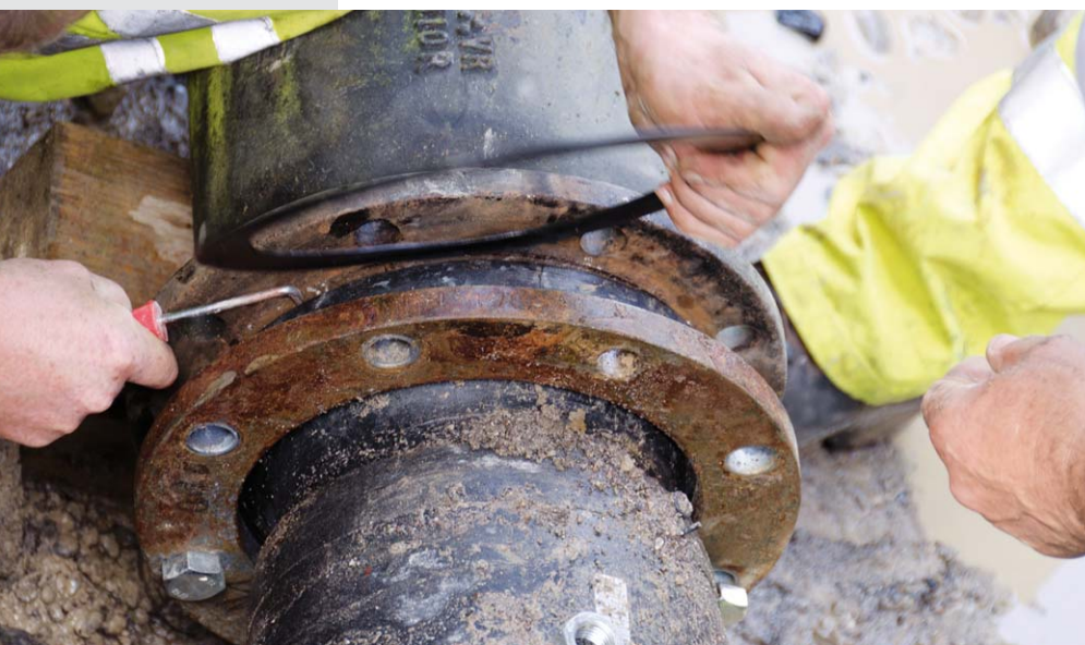
Zusammenschrauben einer Flanschverbindung
