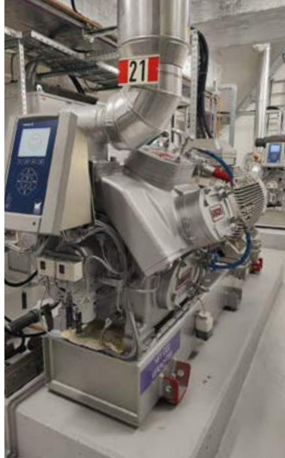
Wärmepumpe Fernwärmezentrale
